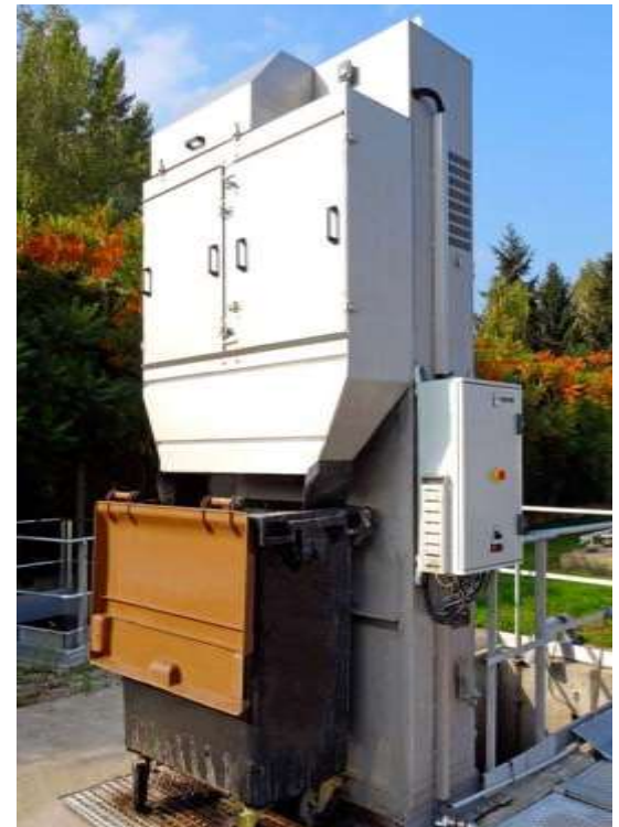
DEGRILLEUR VERTICAL A CABLES
